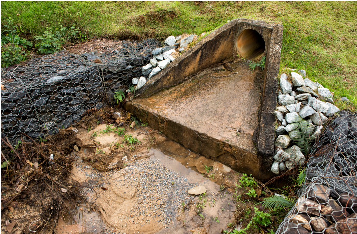
Vista de uma das bacias de detenção (1) implantadas e das canaletas impermeabilizadas (2) que conduzem água ao dique implantado ao fundo do terreno.
